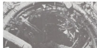
Abb. 5: Teilzusammenbruch eines Grubensbaus beim Tangshan Erdbeben (YONG et al. 1988)
